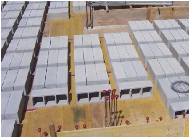
MODULO DE 3 PIEZAS CASETONES CONVENCIONALES DE HORMIGON
