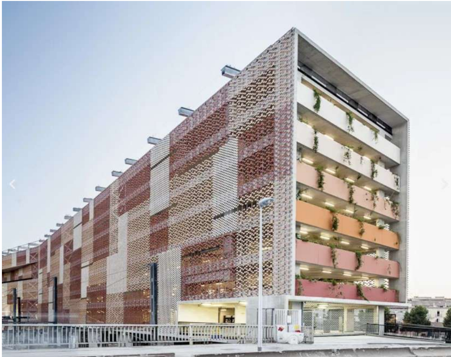
APARCAMIENTO SAINT ROCH-MONTPELLIER. Archikubik Studio
